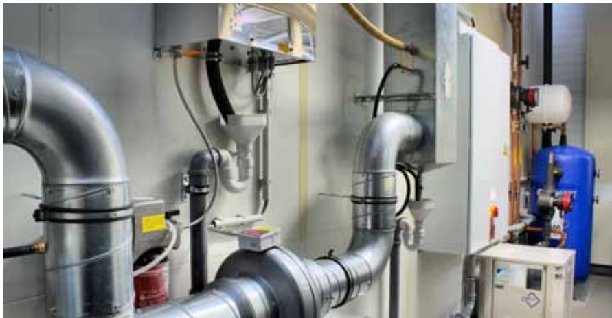
Ein aktives Klimasystem sorgt dafür, dass im Messraum an jeder beliebigen Stelle garantiert die eingestellte Temperatur mit einer Abweichung von lediglich \pm 0,2 Kelvin konstant eingehalten wird.
