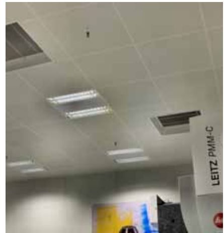
Aus der Decke strömt die temperierte Luft in passender Geschwindigkeit und wird dort auch wieder abgesaugt.
