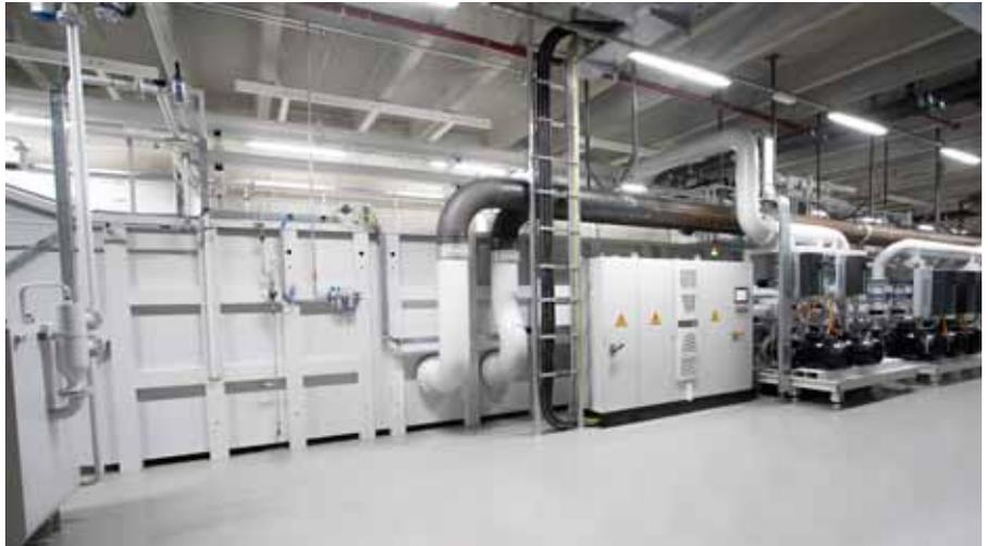
**Überzeugt durch hohe Schleifölqualität, konstante Temperatur und moderate Kosten: Die Zentralanlage von Knoll basiert auf MicroPur-Filtertechnik. In der Endausbaustufe werden bis zu 12 000 Liter Schleiföl pro Minute gereinigt zur Verfügung gestellt.**
