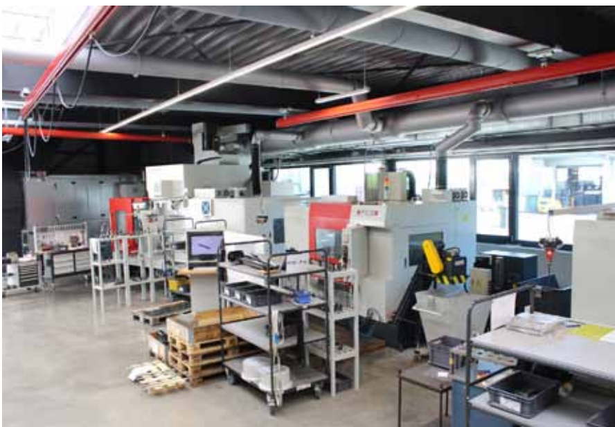
Büchel passte die zentrale Absauganlage inklusive Be- und Entlüftung für Hinkelmann genau an die spezielle Gebäudeform des Neubaus an.
