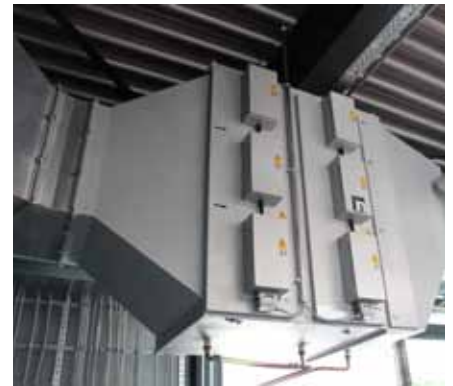
Ein elektrostatischer Luftfilter mit mechanischem Vorabscheider sorgen für den gewünschten Filtrationsgrad.
