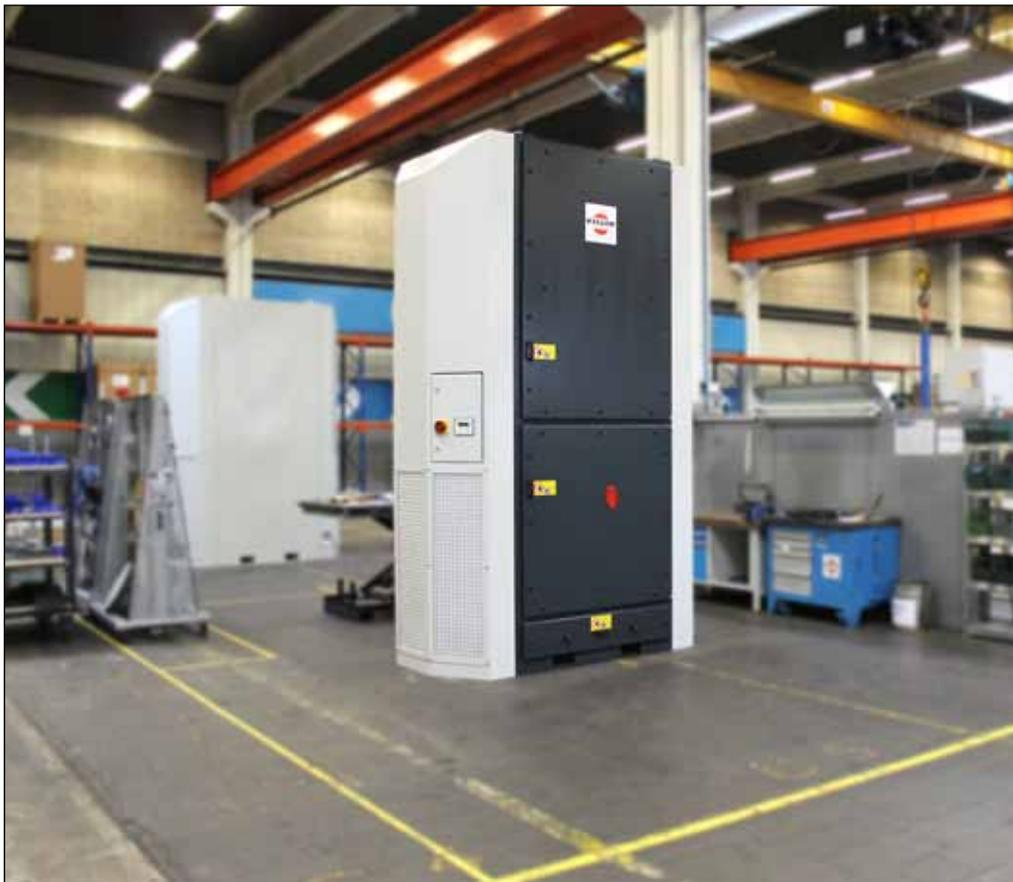
Der AmbiTower von Keller Lufttechnik saugt die staubbeladene Luft im oberen Bereich der Halle ab und führt sie im Aufenthaltsbereich der Mitarbeiter gereinigt wieder zu. So schafft eine Kombination aus Absaugung an Bearbeitungsmaschinen und Raumabsaugung durch den AmbiTower optimale Luftverhältnisse und senkt die Grundbelastung mit luftfremden Stoffen wie Feinstaub, Viren, Bakterien, Pilzen, Pollen und Sporen drastisch.
