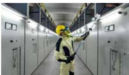
ge als auch ein akustisches Signal zeigen an, ob Spannung anliegt. Ebenso ist der Spannungsprüfer für den Innen- und Außenbereich sowie bei Niederschlägen einsetzbar. Ist ein größerer Schutzabstand für die sichere Handhabung notwendig, oder reicht die Länge nicht aus, um die Antaststelle zu erreichen, so ist schnell und einfach eine Verlängerung montierbar.
