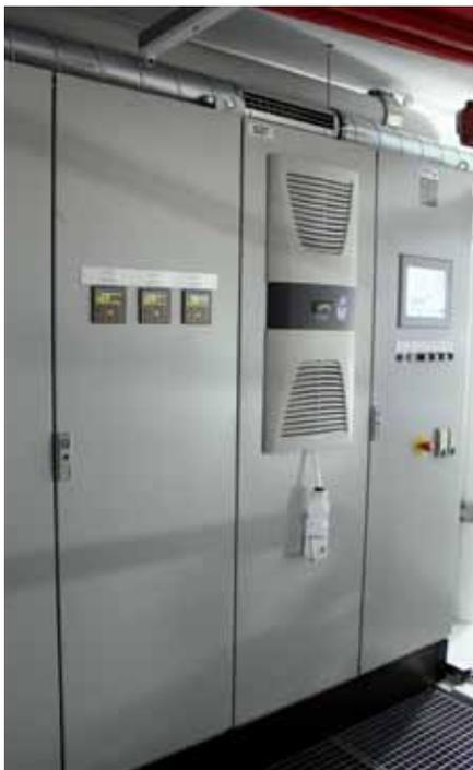
**Schaltzentrale: Von hier aus werden die drei Filterstränge gesteuert.**
