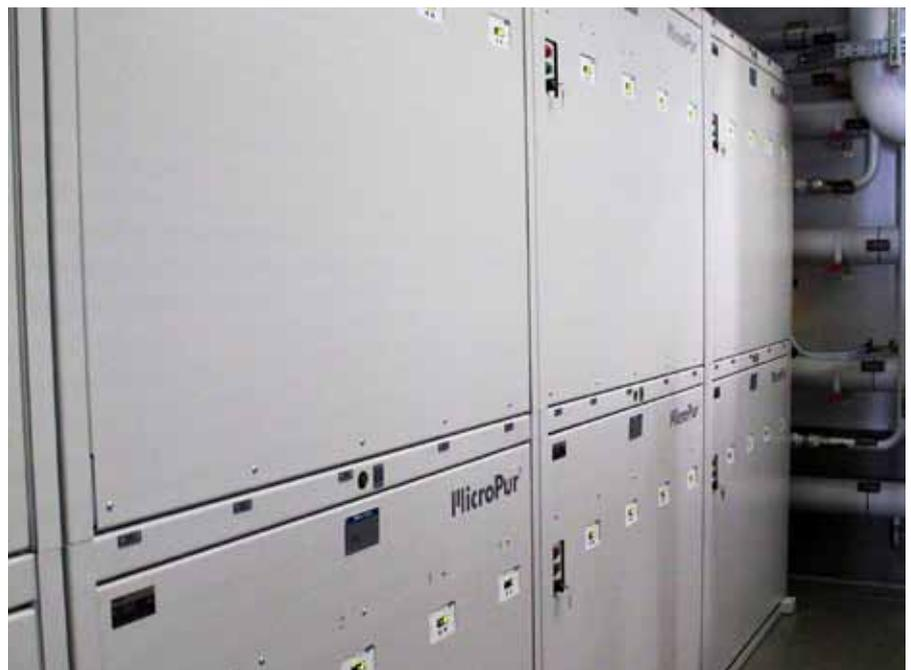
Um die hohe Qualität des Schleiföls sicherzustellen, entschied sich Emuge für eine Zentralanlage zur KSS-Reinigung vom Filtrationsspezialisten Knoll Maschinenbau.
