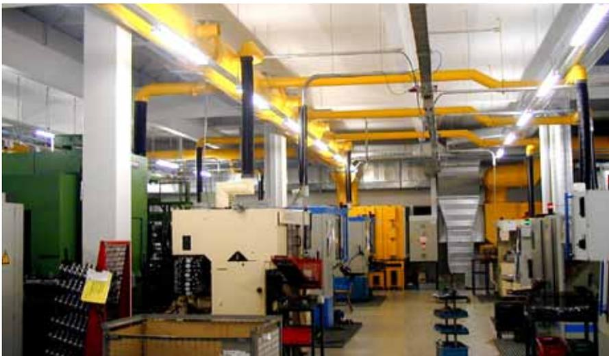
Eine zentrale Büchel-Absauganlage auf engstem Raum wurde in die bestehende Fertigung integriert – inklusive Be- und Entlüftung sowie Wärmerückgewinnung.
