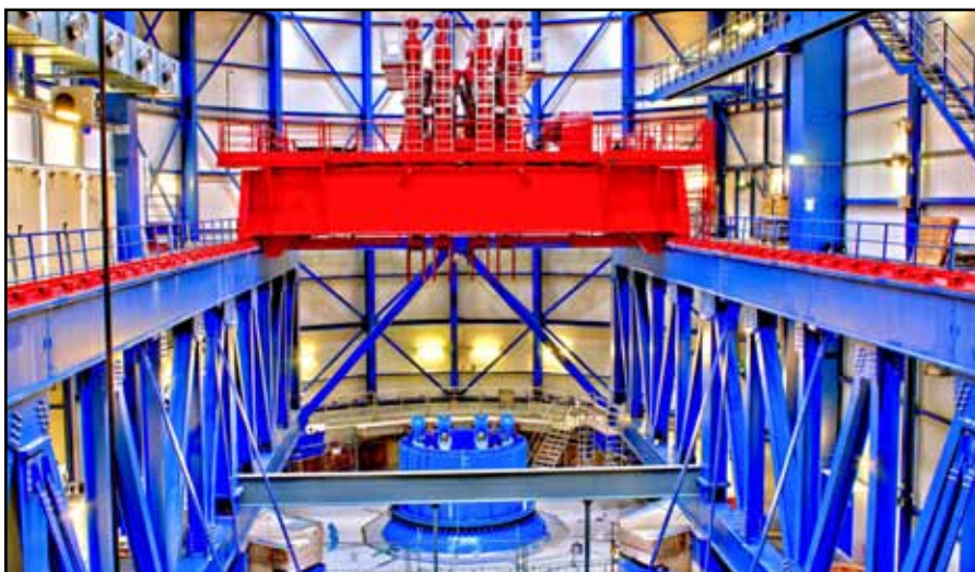
Gewaltige Gewichte kann die eigens zur Reaktor-Demontage eingebaute Hebevorrichtung aufnehmen. So erfolgt der Rückbau des Kraftwerks auf hohem Sicherheitsniveau.
