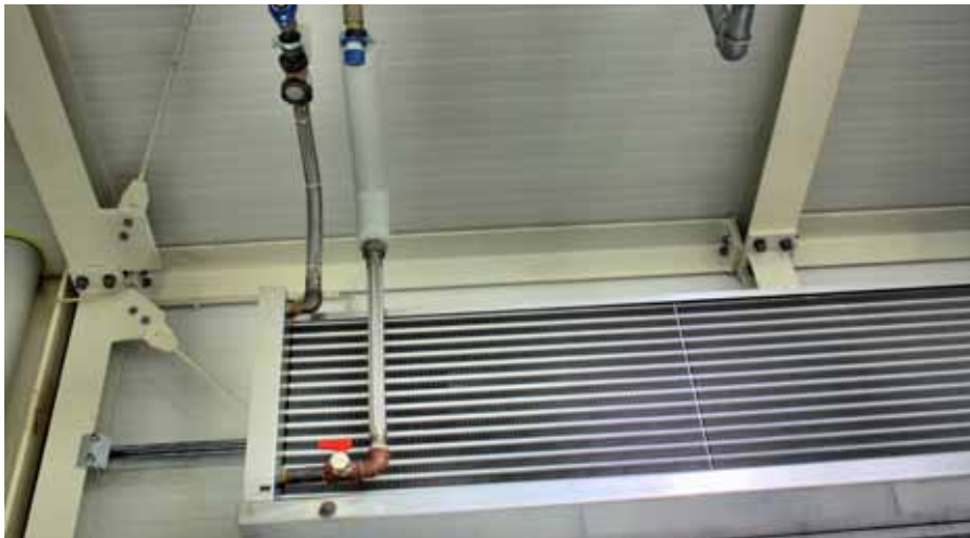
Von Wasser durchströmte Rohre sorgen dafür, dass die erwärmte Luft abkühlt und in der Folge im Graviert nach unten sinkt.
