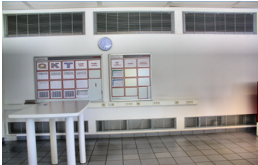
Mit Schwerkraftkühlungsanlagen des Ingenieurbüros Güttinger lassen sich lärmfrei und mit wenig Energieaufwand selbst große Hallen temperieren.
