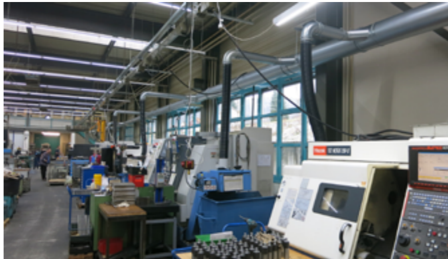
Über die Gruppenabsaugung werden Abgase des kompletten Maschinenparks in Voll- last, aber auch während Halblastzeiten optimal abgeführt und gereinigt.
