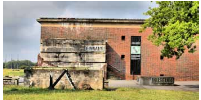
Die ehemalige Schaltwarte des bis 1991 betriebenen Kohlekraftwerks wird heute als Eingang zum Peenemünder Raketenmuseum genutzt.
