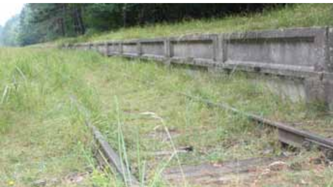
Eine Bahn transportierte die etwa 15 000 Bewohner der Heeresversuchsanstalt an ihre Dienstorte beziehungsweise Wohnsiedlungen. Reste eines Bahnsteigs sind noch heute zu sehen.
