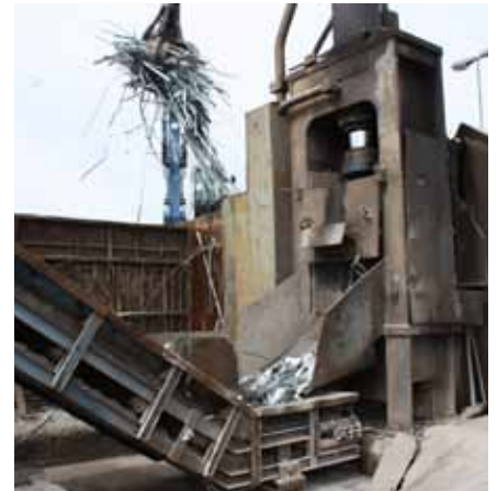
Eine 800-Tonnen-Schere zerschneidet und verdichtet Stahlschrott.
