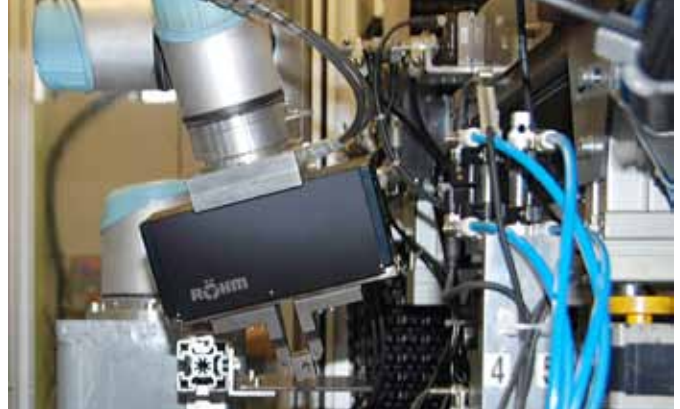
Der Roboterarm mit dem Röhm-Greifer schwenkt innerhalb der engen Platzverhältnisse von der Senkrechten in die Waagrechte.
