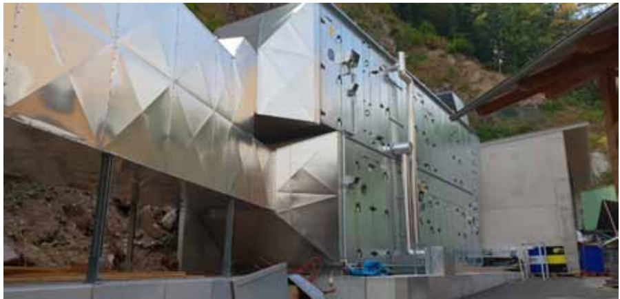
Ein Wärmetauscher in der an die Absaugung angeschlossenen Be- und Entlüftungsanlage reduziert den Energiebedarf und ermöglicht deswegen die staatliche Förderung.
