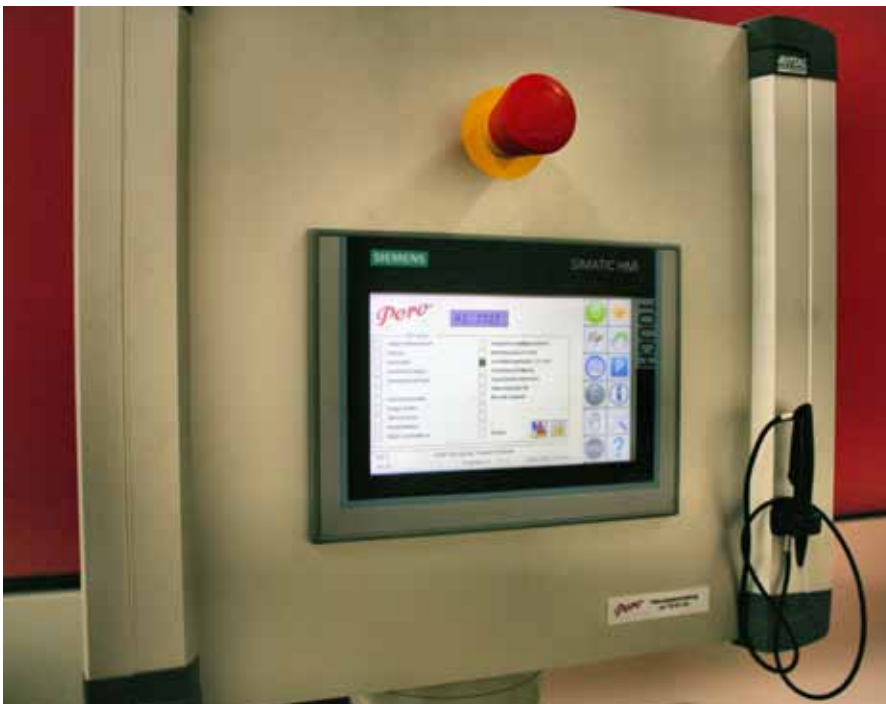
Über eine einfach zu bedienende Steuerung werden Pero-Anlagen bedient und Reinigungs- sowie automatisierte Wartungsprogramme aufgerufen.
