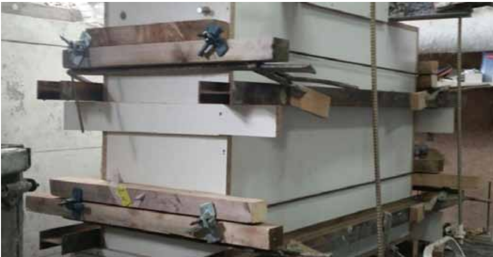
Die Schalung für den 3D-gedruckten Voxeljet-Firmenstein aus Beton besteht aus einer Kombination aus gedruckten und herkömmlichen Schalungselementen.
