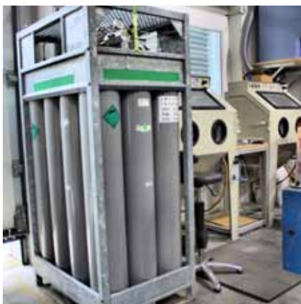
Das benötigte Schutzgas lagert in Flaschenbündel. Die Umschaltung zwischen den Gasen erfolgt automatisch.
