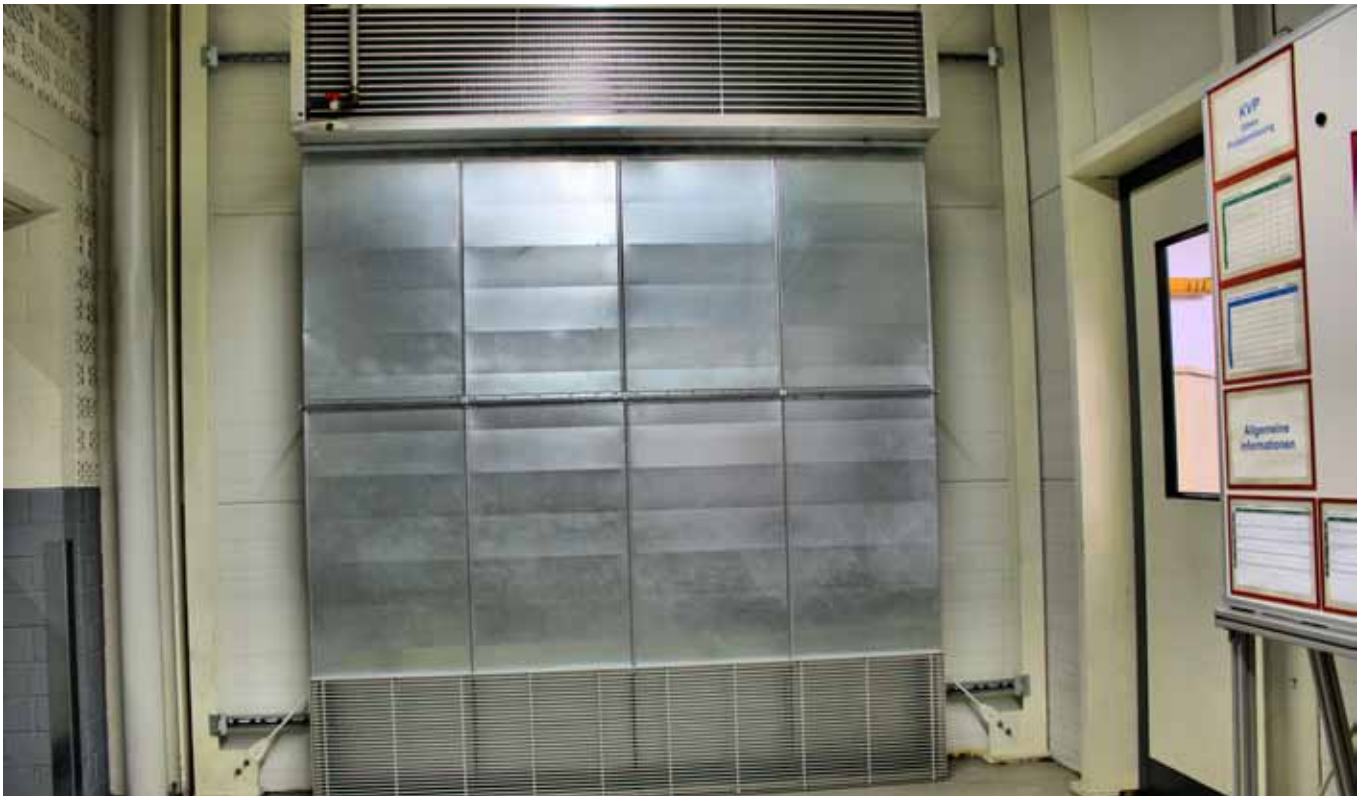
Eine von Dipl.-Ing. (FH) Kurt Güttinger geplante Schwerkraftanlage ist optimal auf den jeweiligen Anwendungsfall ausgelegt. Eine vor dem Einbau durchgeführte Simulation stellt sicher, dass die eingebaute Anlage die Ansprüche perfekt erfüllt.
