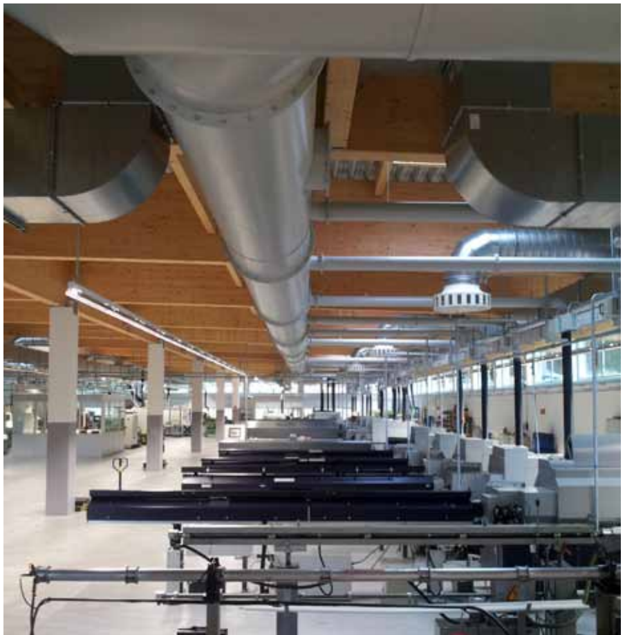
Die Absauganlage für das neue Tritschler-Werk legte Büchel mit Reservekapazität aus, sodass auch später noch weitere Maschinen problemlos daran angeschlossen werden können.
