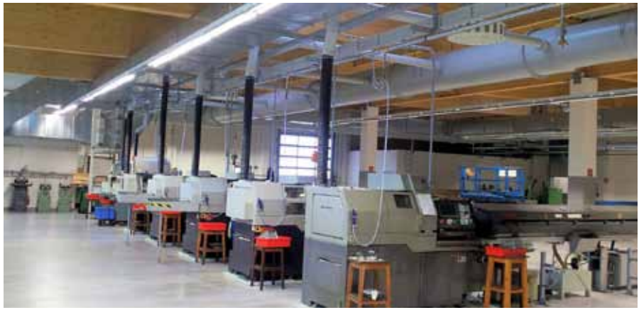
Büchel stimmte die Absauganlage im neuen Tritschler-Werk perfekt auf den gesamten Maschinenpark ab.
