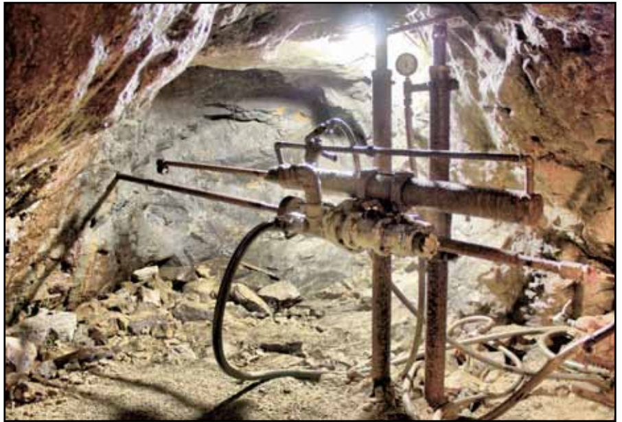
Testbohrungen von bis zu hundert Meter Tiefe zeigen, ob es sich lohnt, an dieser Stelle den Abbau von Graphit weiterzuverfolgen.
