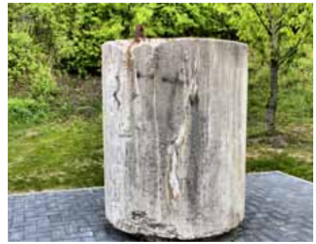
Zur stärkeren Abschirmung wurden Stahlfässer mit Beton ummantelt. Dazu wurde Normal- und Schwerbeton verwendet.
