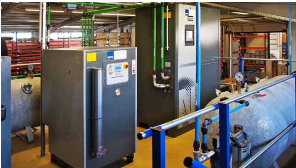
Der im N 2 -Generator von Atlas Copco erzeugte Stickstoff wird mit dem Booster auf bis zu 300 bar nachverdichtet und anschließend in einem Flaschenbündel zwischengespeichert.
