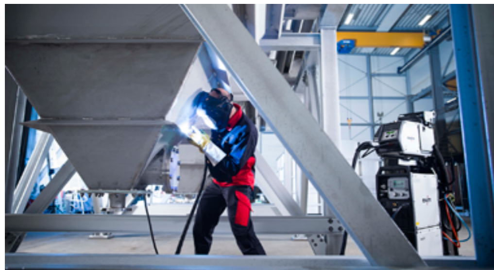
Schweißen von Chrom-Nickel-Stahl mit dem Schweißprozess ›forceArc puls‹. Die Schweißrauchemissionen sinken um das 4,5-fache gegenüber dem konventionellen Schweißverfahren.
