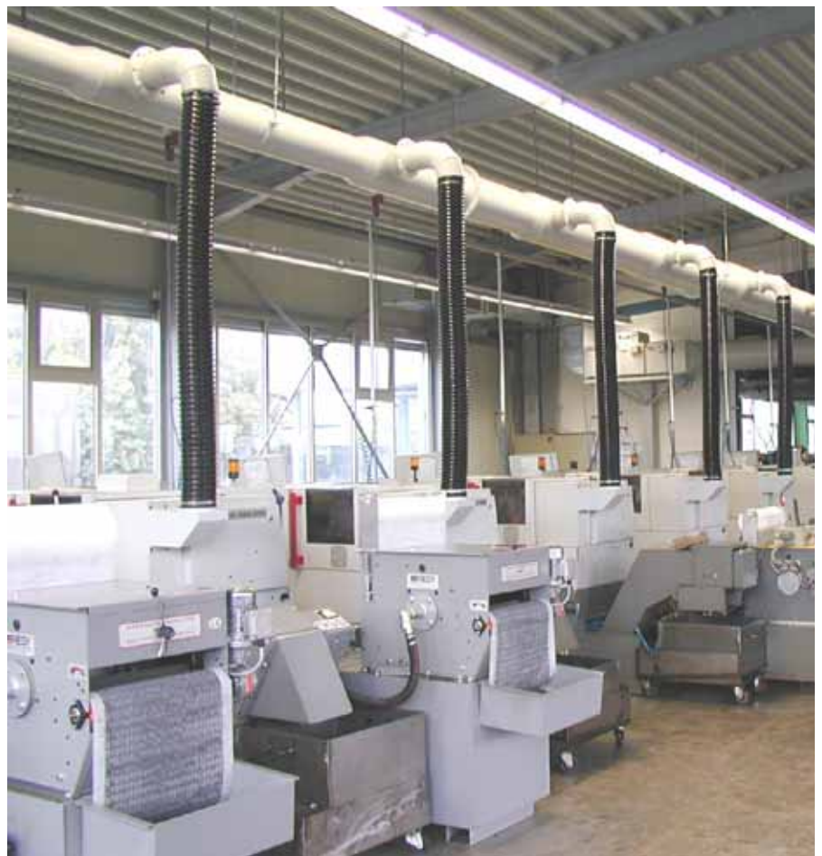
Die Gruppenabsaugung von Büchel filtert mit einem zweistufigen Elektrofilter sowohl Öl als auch Kühlschmierstoff aus der Luft heraus.
