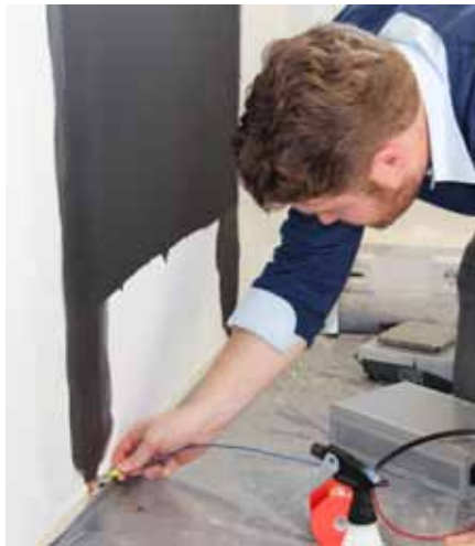
Damit Strom fließt, müssen zwei Kupferbänder installiert werden.
