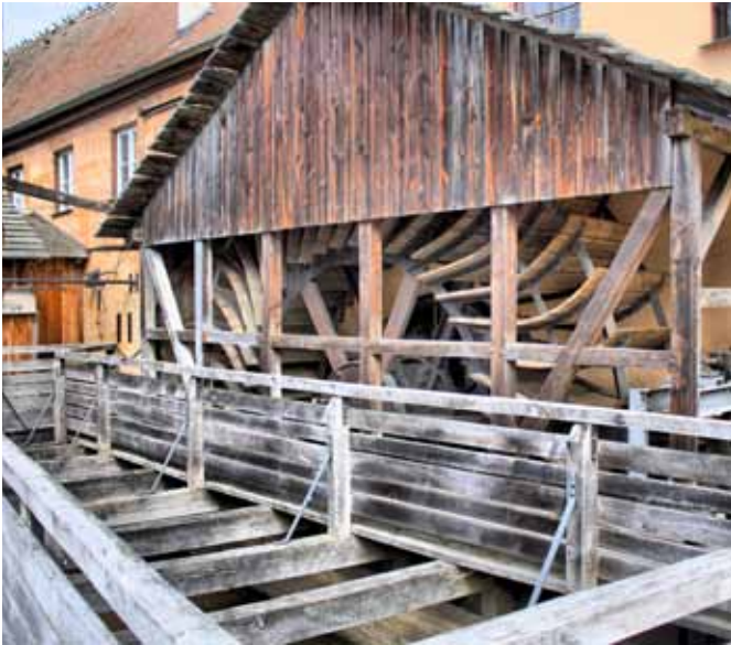
Vier Wasserräder lieferten die Kraft, die die Mühle, das Hammerwerk und das erste Laufer Elektrizitätswerk benötigten. Ab 1899 lieferte letzteres Strom für Laufer Haushalte und Kleingewerbe.
