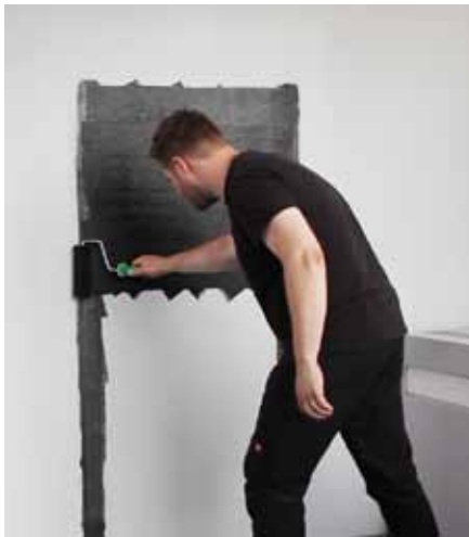
Innovativ: eine Wandheizung kann via »e-Paint« mit der Rolle erstellt werden.
