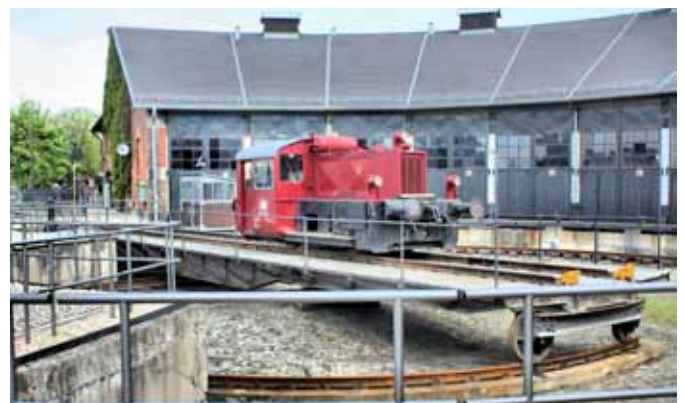
Damit Dampfloks mit dem Schornstein voraus ihrem Ziel entgegenfahren konnten, mussten diese bei Bedarf mittels einer Drehscheibe gewendet werden.
