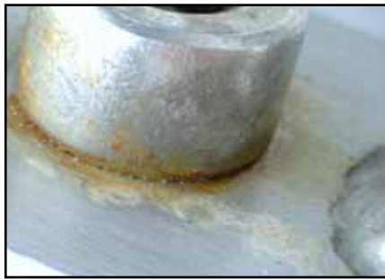
Spaltkorrosion tritt an Schweißnähten oder aufgesetzten Teilen auf.
