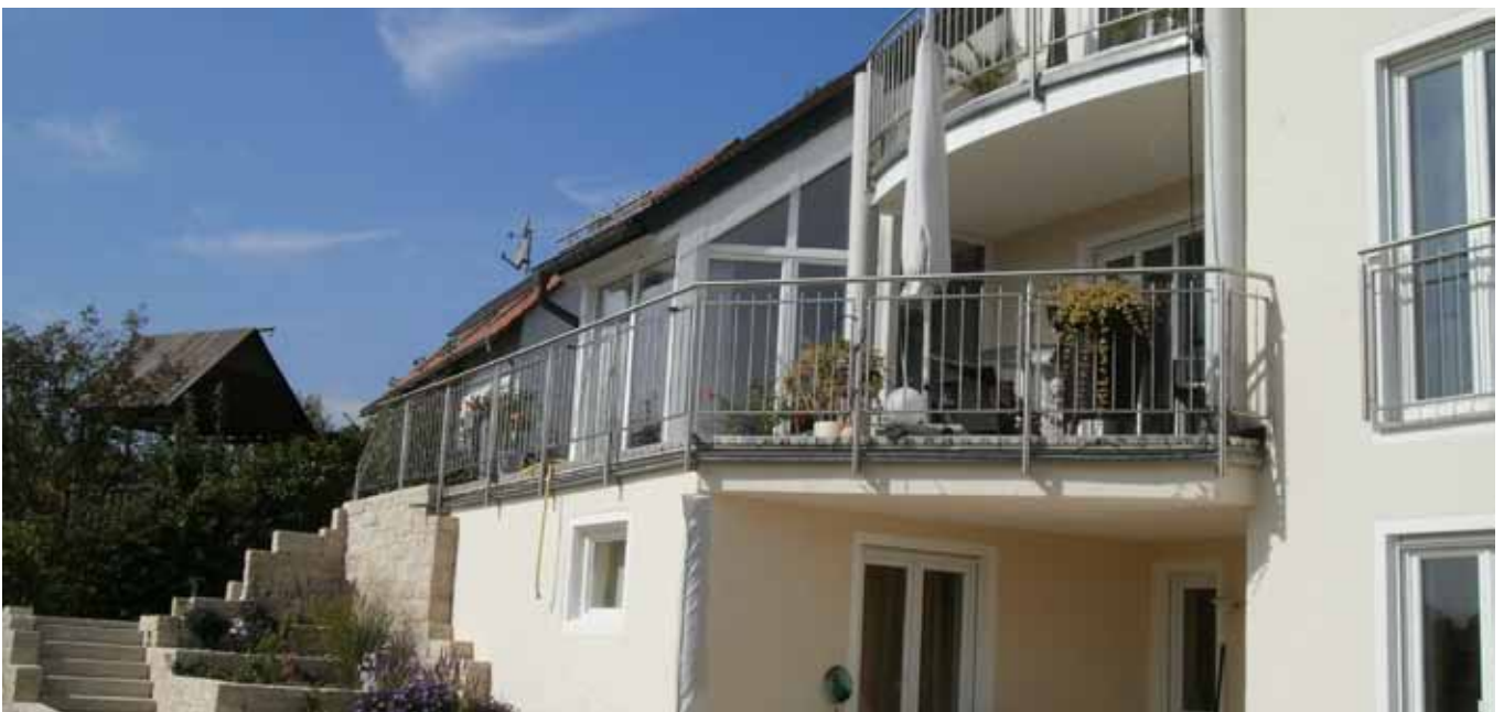
Geländer und Treppenläufe aus Edelstahl-Rostfrei sind beliebt, weil pflegeleicht. Ihre Herstellung will jedoch wohlgeplant sein und muss mit eigenen Werkzeugen erfolgen, sollen sie auf Dauer rostfrei bleiben.
