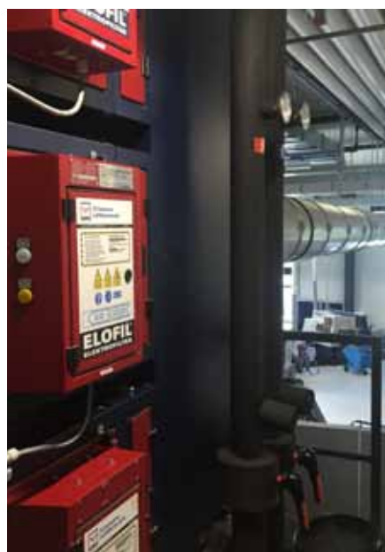
Elofil-Luftfilteranlagen von ILT sorgen bei Krontec für saubere Hallenluft.
