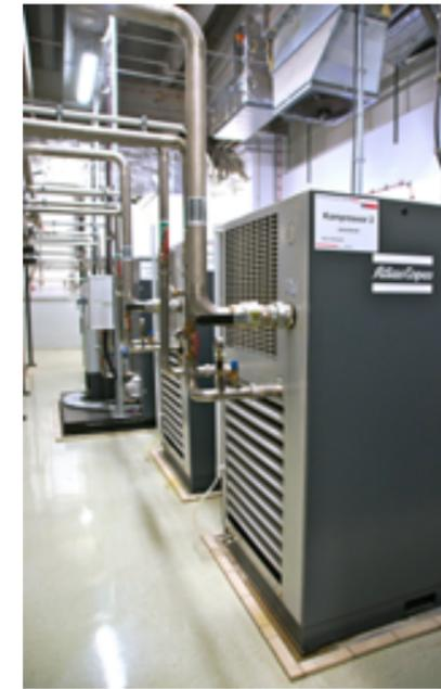
**Druckluftstation beim Papierhersteller Propapier. Der Druckluftverbrauch wird kontinuierlich gemessen und im Betriebsleitsystem dokumentiert.**
