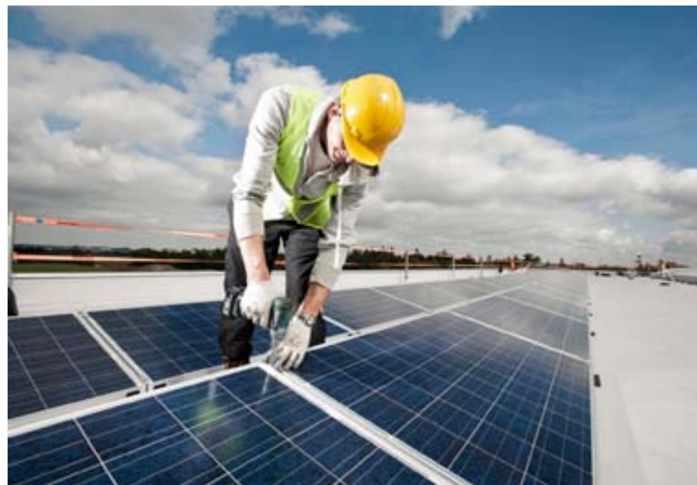
Solar-Dienstleister Goldbeck deckt 50 Solardächer im Jahr. Vor allem auf Logistik- und Industriehallen. Hier setzt man auf individuelle Weiterbildung.
