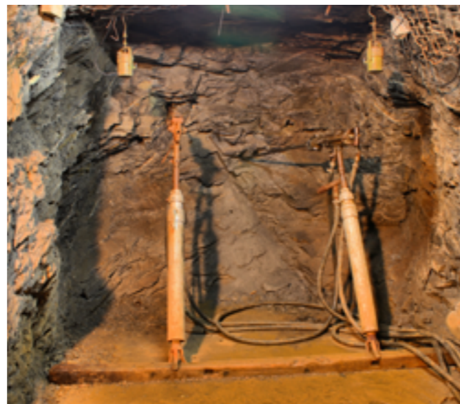
Obwohl druckluftbetriebene Bohrer einen Höllenlärm machen, waren sie bei den Bergleuten beliebt, da damit die Arbeit sehr erleichtert wurde.
