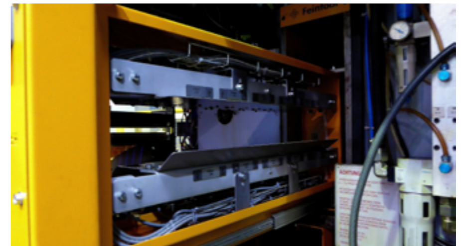
Die Sprüchkammer enthält alle zur Versorgung der Band-Befettung notwendigen Leitungen und Anschlüsse für das Medium, Luftdruck und Elektrik.
